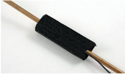
5) Recouvrir le capteur d'isolant thermique sur au moins 10 cm aux extrémités du bouchon et du câble enroulé;
